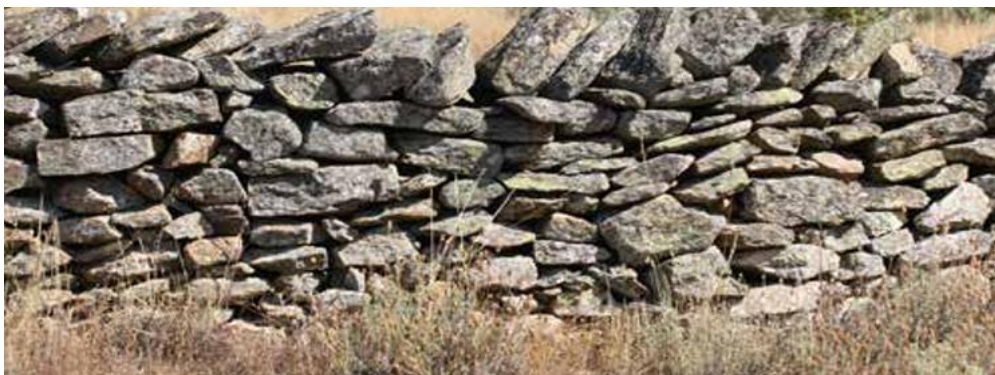
Muros de piedra seca habituales en la zona, donde se han creado las oquedades
