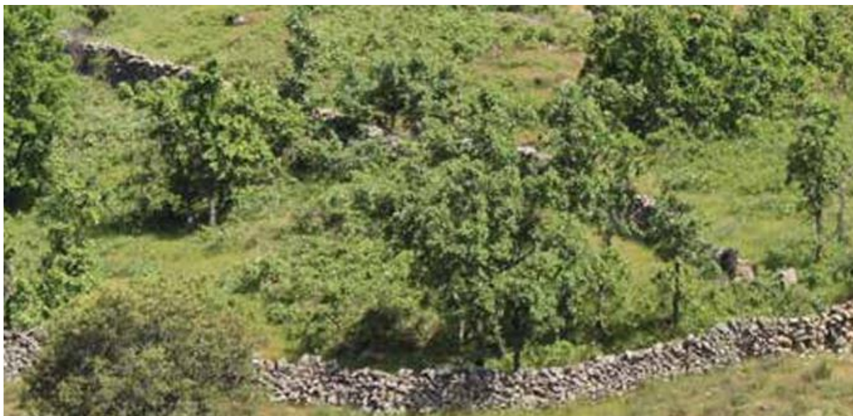
Delimitación de parcelas con muro de piedra seco
